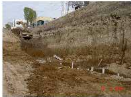
Excavación a cielo abierto
