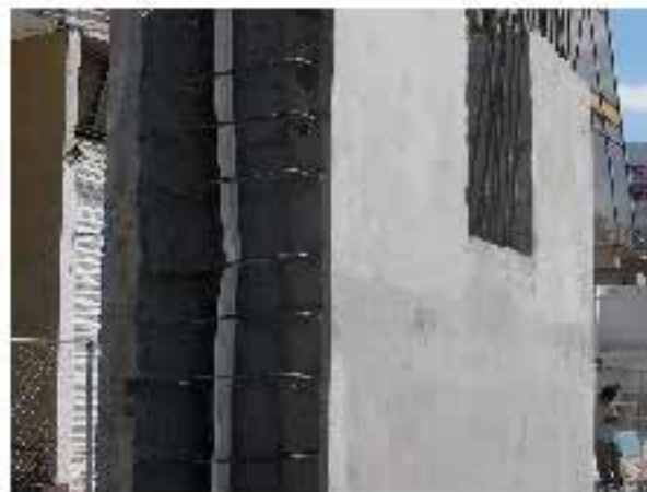
Banda de PVC en unión lateral con muro y con losa de fondo
