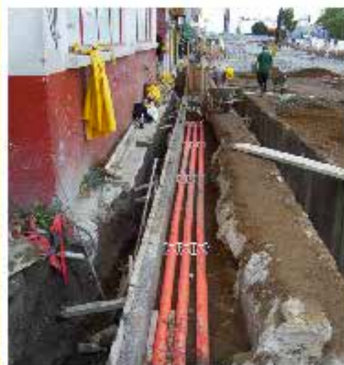
Ejemplo de colocación de tubería PAD (polietileno de alta densidad) en obras inducidas.
