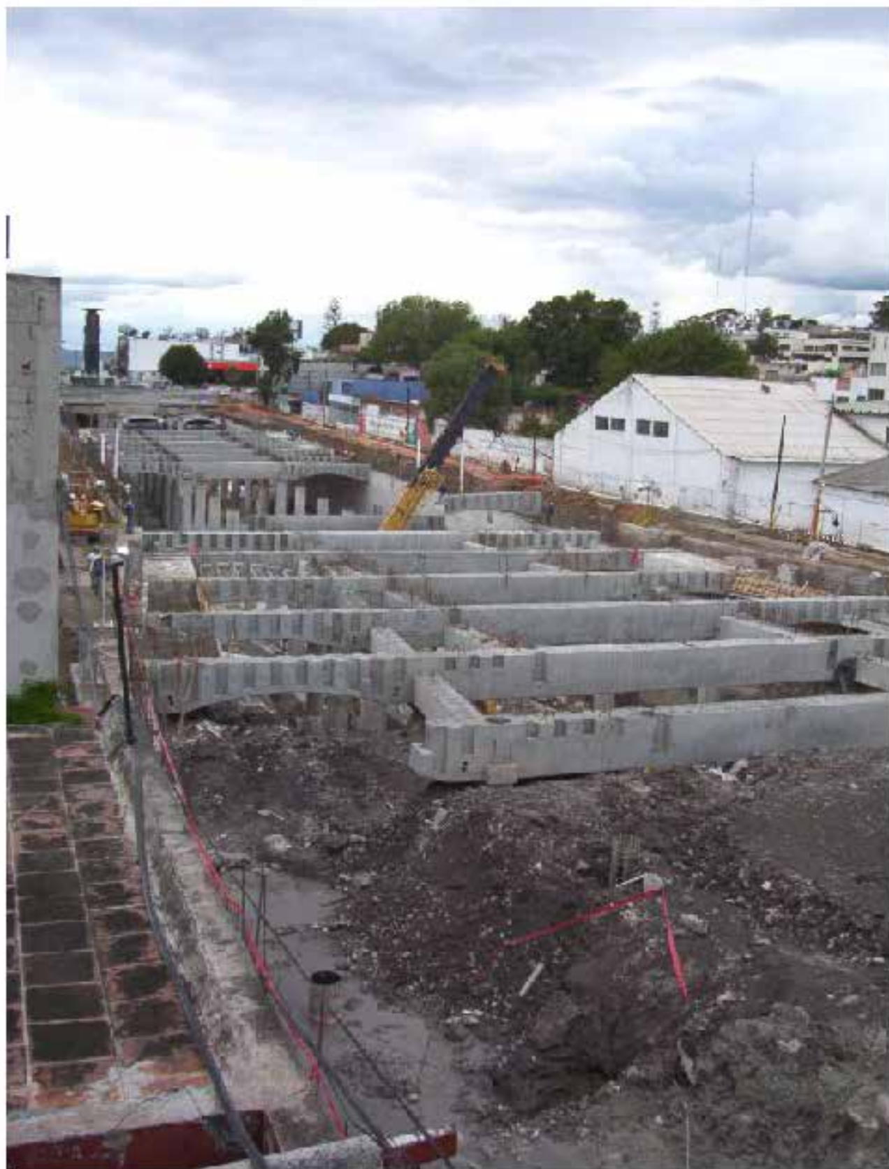
Proceso de colocación de elementos prefabricados
