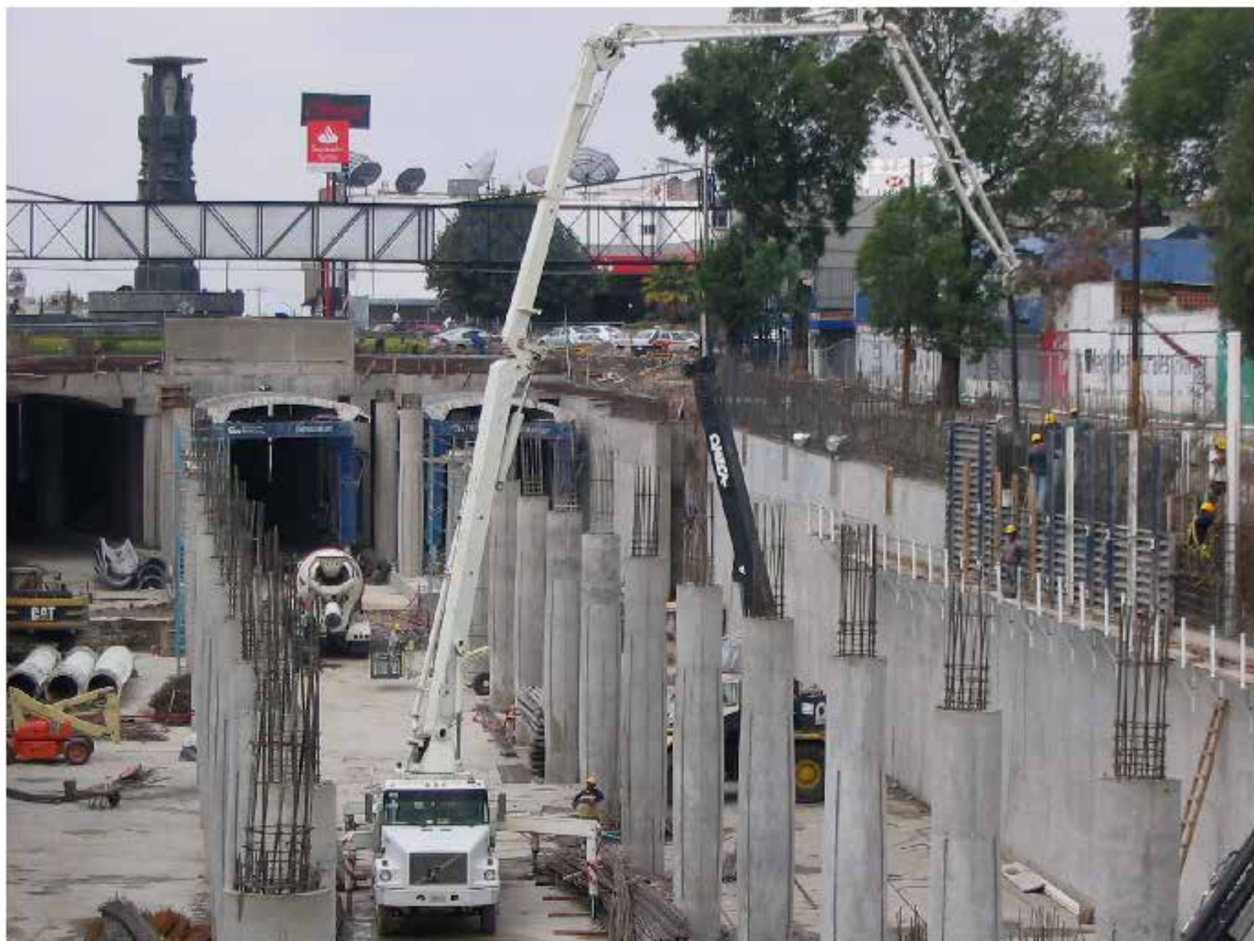
Construcción de muros laterales en la zona a cielo abierto
