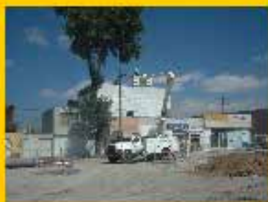
Relocalización de instalaciones aéreas
