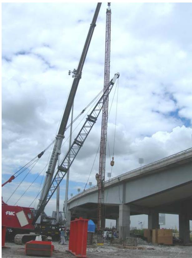
Figura 3. Armado instrumentado de la pila de prueba
