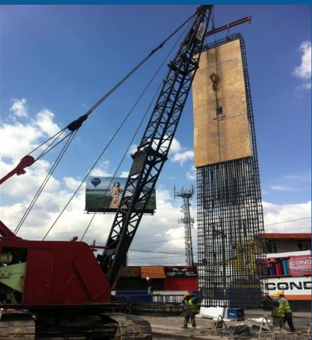
Colocación de acero de muro Milán
