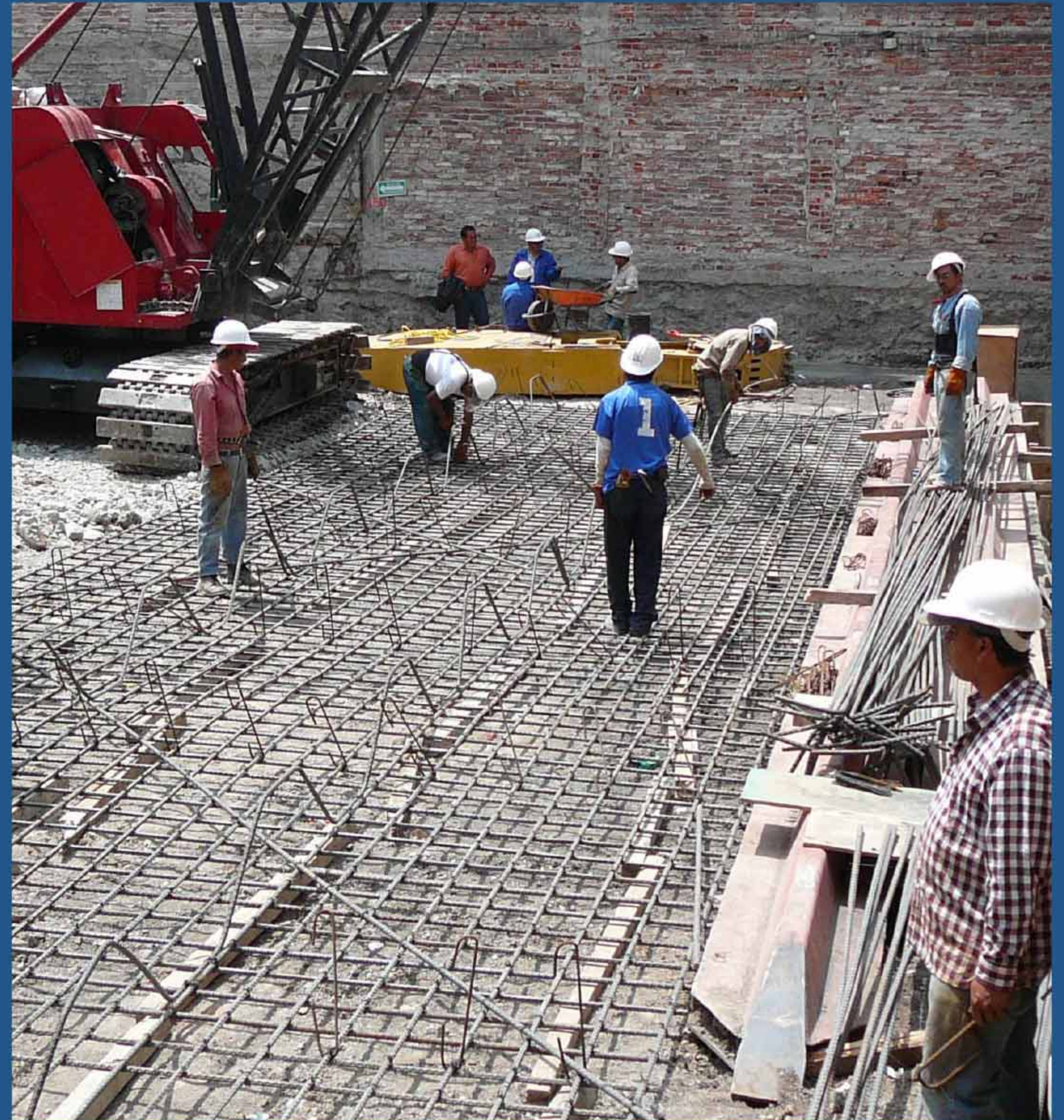
Construcción de armado de muro Milán
