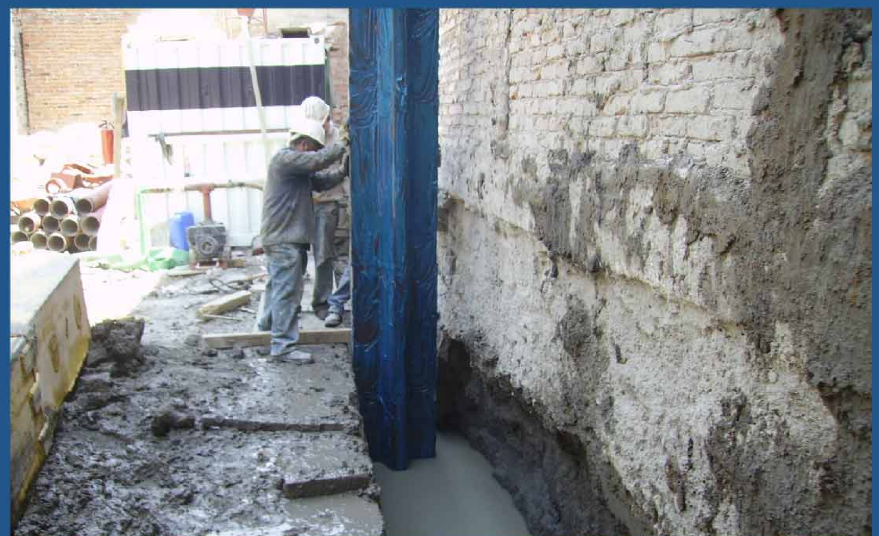
Colocación de juntas
