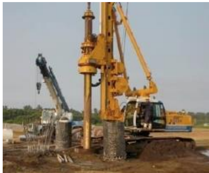
a) Procedimiento constructivo I: perforación con hélice continua y ademe, utilizando una cabeza rotaria doble. b) Procedimiento constructivo II: perforación con Kelly telescópico, lodo bentonítico y ademe metálico en una porción de la perforación.
