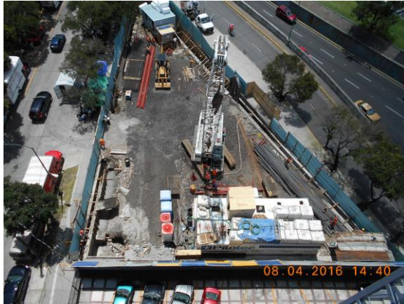
Fig. 2 Diferentes entornos de construcción de pilas de cimentación.
