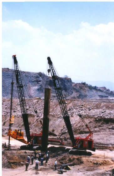
a) Ademe en perforación previa
