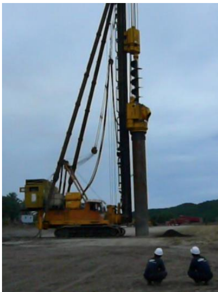
a) Procedimiento constructivo I: perforación con hélice continua y ademe, utilizando una cabeza rotaria doble. b) Procedimiento constructivo II: perforación con Kelly telescópico, lodo bentonítico y ademe metálico en una porción de la perforación.
