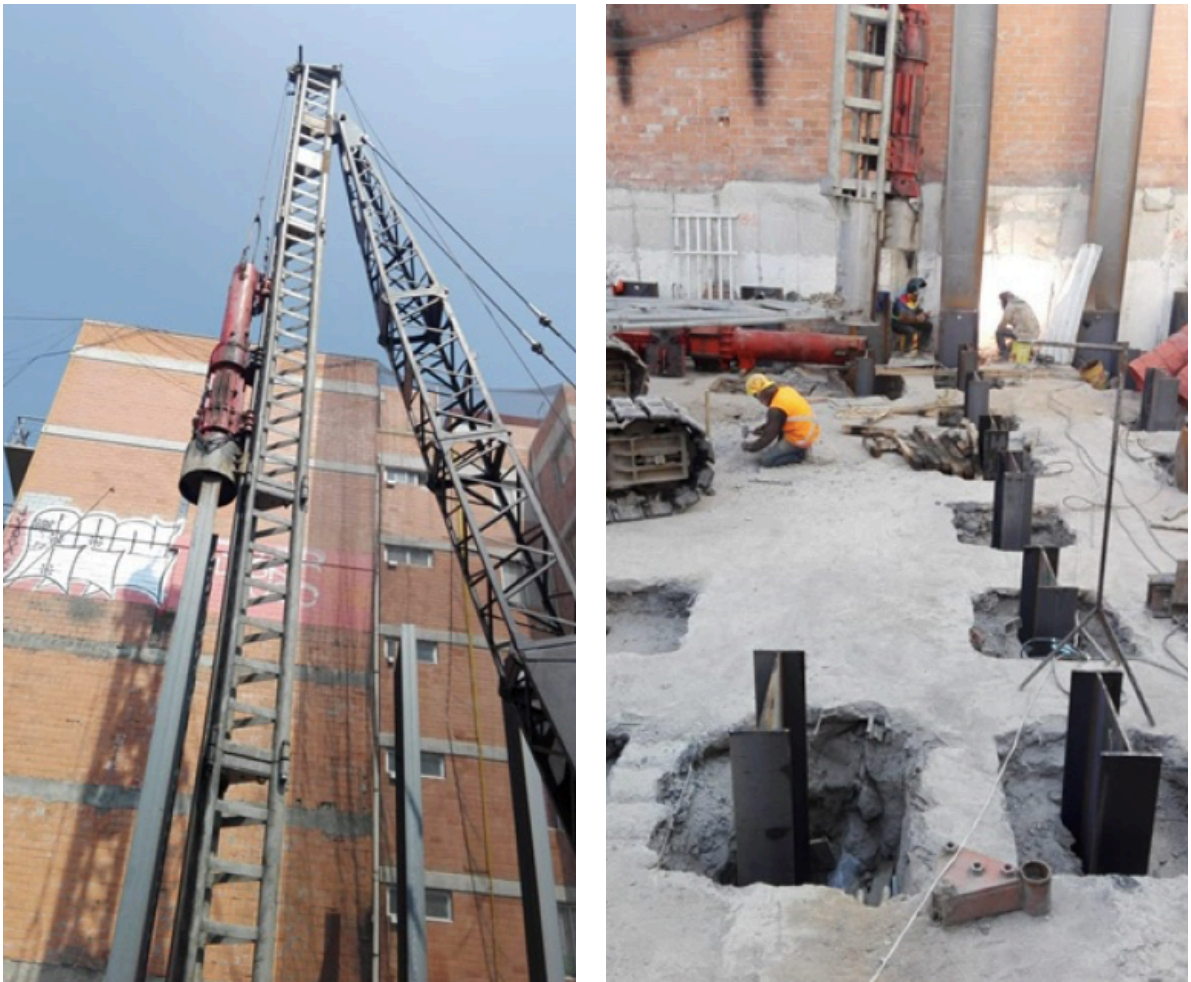
Figura 5, Pilotes metálicos H, hincados en 2018, en la Ciudad de México.
