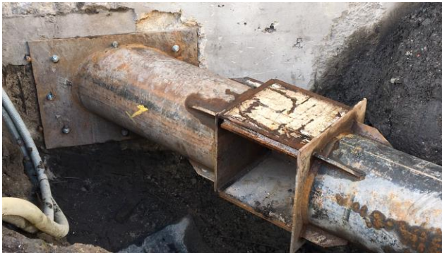
Figura 10. Troquel de acero fijado con placa y tornillos al muro Milán.
