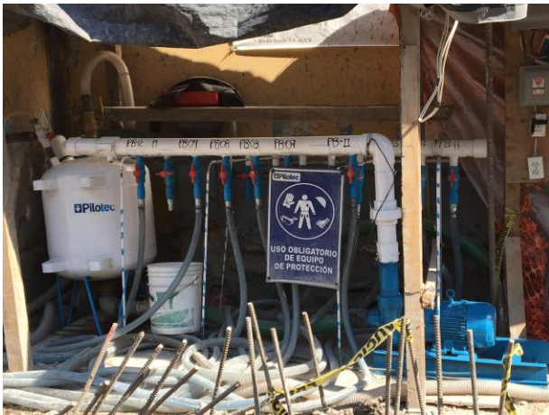
Figura 6. Sistema de bombeo.
