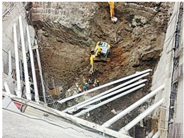
Figura 18. Vista superior del proceso de excavación y apuntalamiento.
