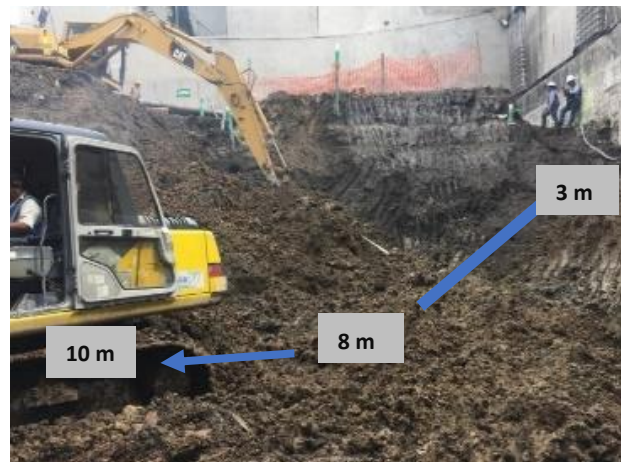
Figura 12. Desviación del procedimiento de excavación.
