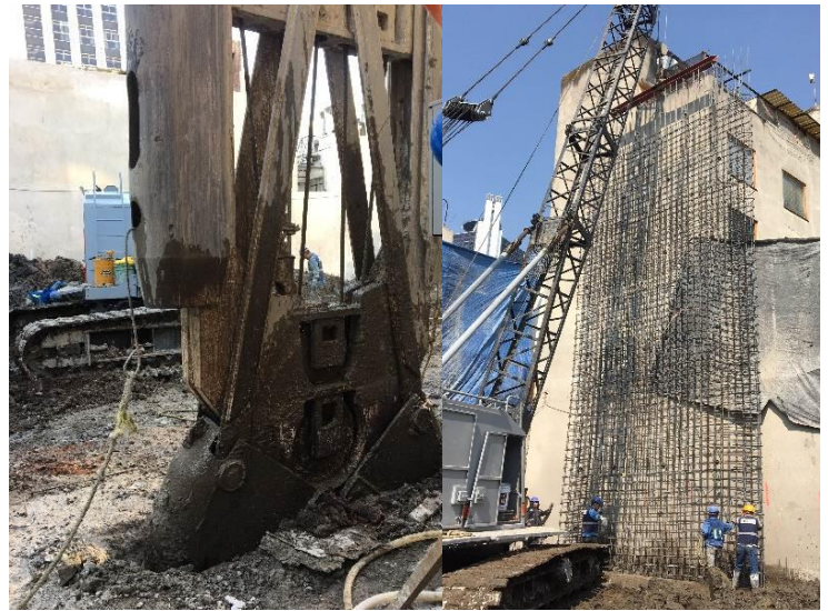
Figura 4. Construcción del Muro Milán
