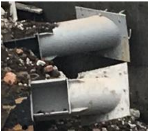
Figura 14. Placas vencidas de los puntales de acero.
