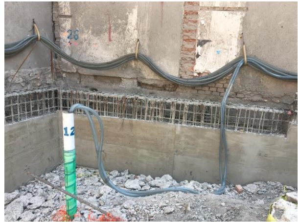
Figura 7. Pozo de bombeo en el sitio. Al fondo, trabe de coronamiento en proceso de construcción.
