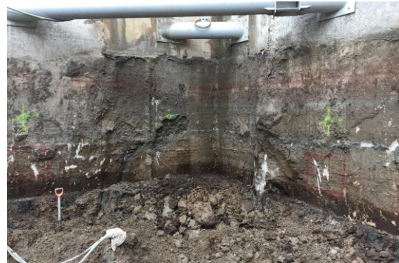
Figura 11. Excavación previa a colocar los troqueles del tercer nivel.
